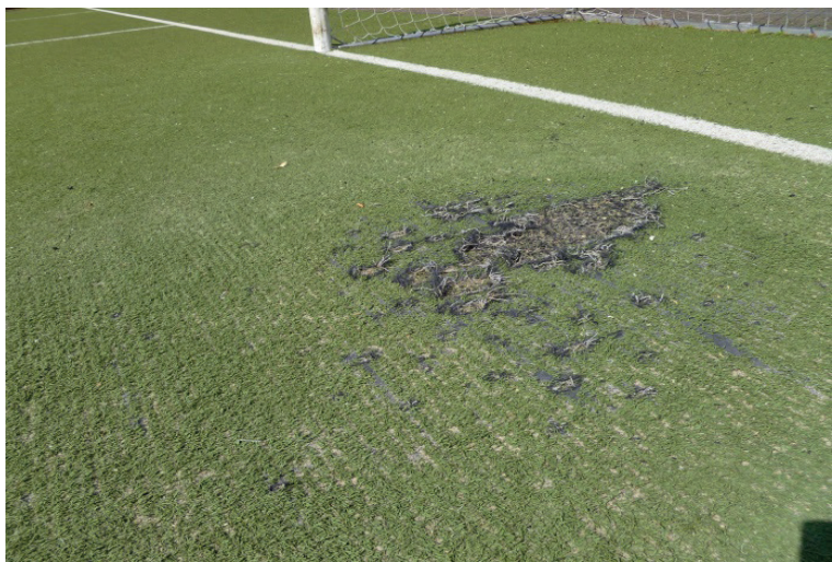
Verschlossener Belag im Torraum
