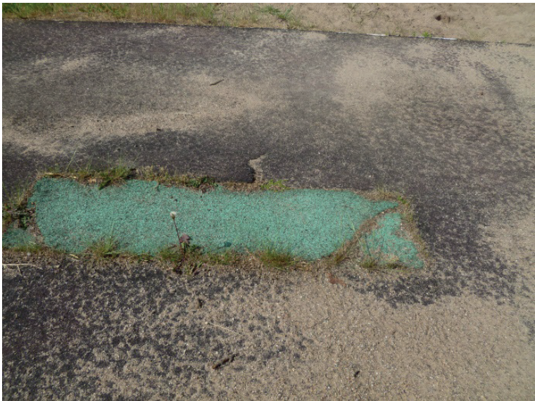
Defekter Belag und Absprungbalken an der Sprunggrube können zu Stolpern und Stürzen von Nutzern führen.
