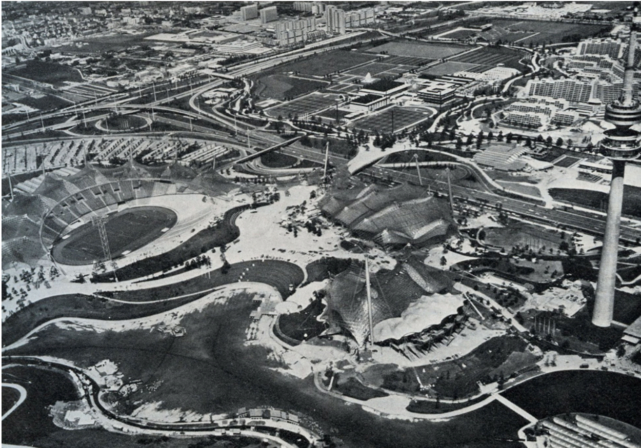
Abb. 3: Errichtung des Olympiaparkgeländes (Quelle: BISp)
