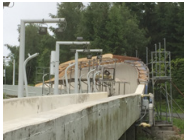
Abb. 8: Umbaumaßnahmen am ENSO Eiskanal Altenberg in Vorbereitung auf die BMW IBSF Bob und Skeleton Weltmeisterschaften 2020 (Quelle: WIA Altenberg)
