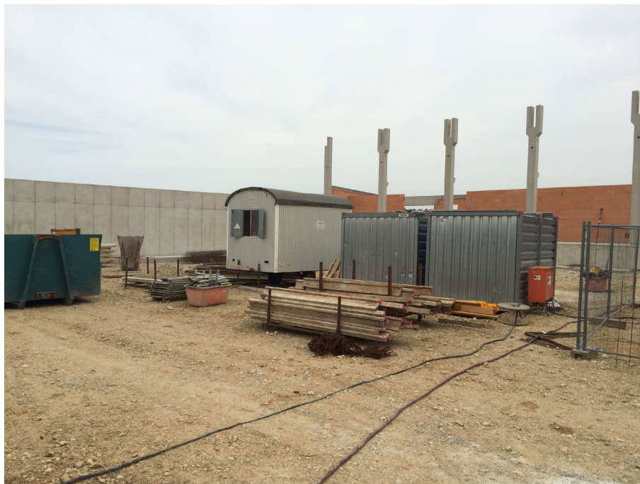
Abb. 4.1: Baustelle der Sporthalle „Am Sportpark, Zorneding“ | Foto: Natalie Eßig
